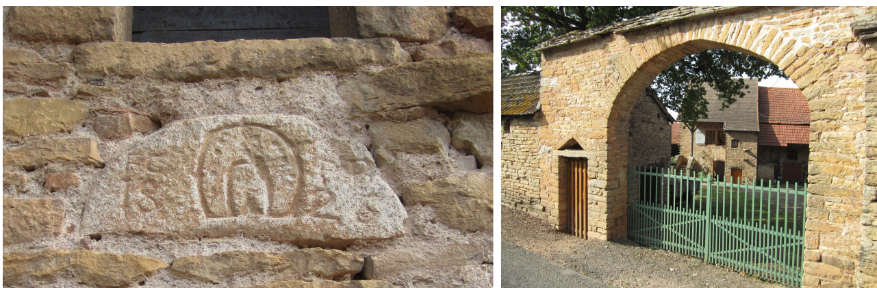
A Sully, au-dessus de sa porte, la marque d'un maréchal-ferrant. Un porche à Vincelles.
